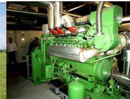
Elementy biogazowni i silnik produkujący energię elektryczną z biogazu
